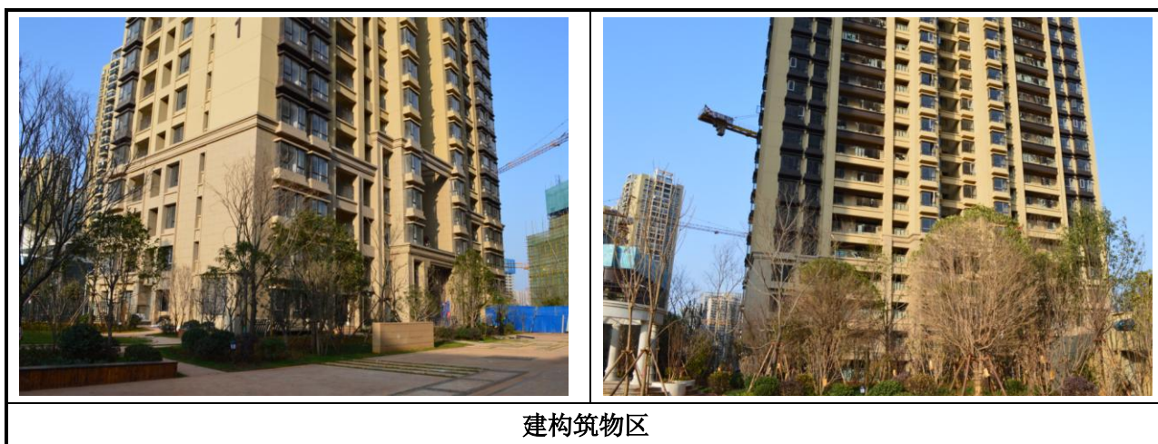
图 1-1 建构筑物区现状
