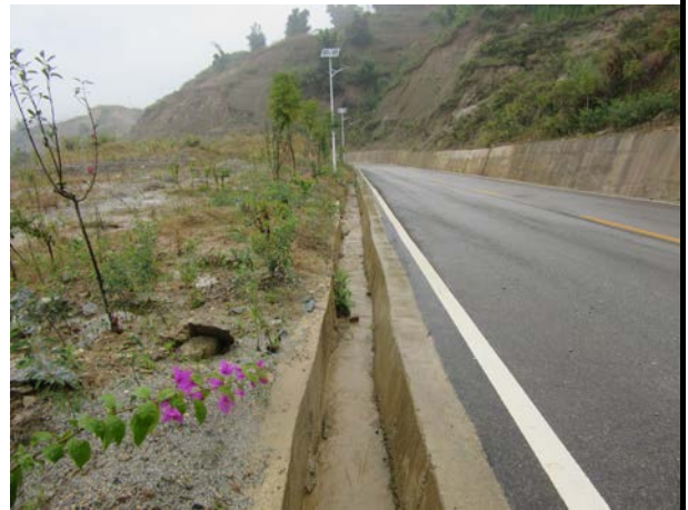
2017年12月 道路区现状情况
