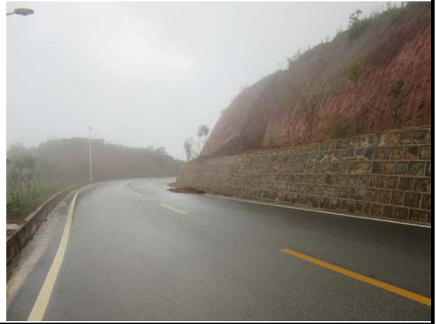
2017年12月 道路区现状情况
