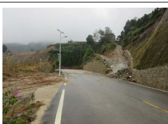
道路路基挡墙措施
