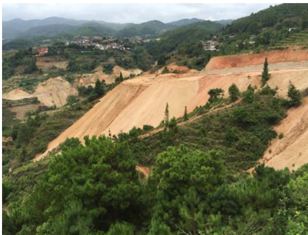
2015年8月 3#弃渣场情况
