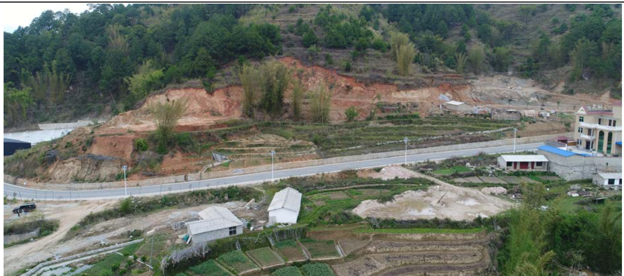
2017年12月 道路区现状情况
