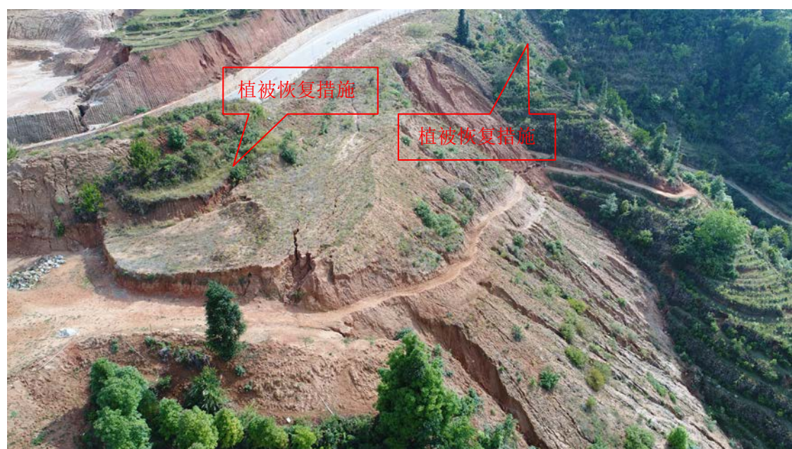
3#弃渣场植被恢复措施现状情况
