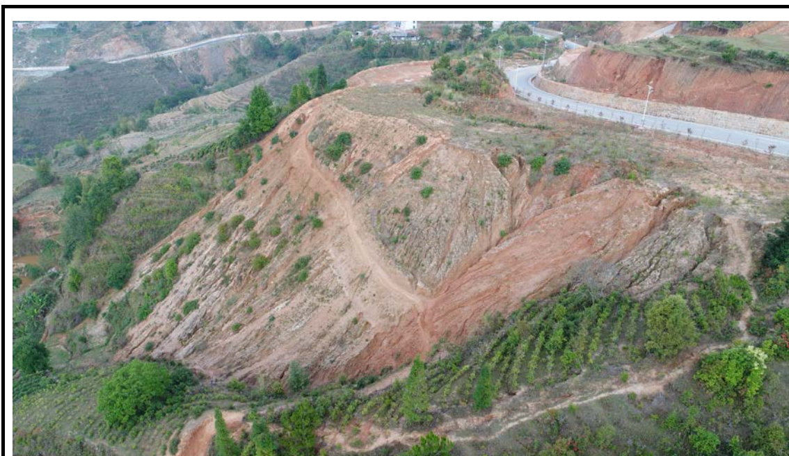
弃渣场区水土流失治理效果
