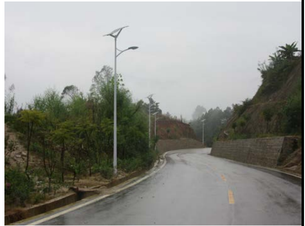
2017年12月 道路区现状情况
