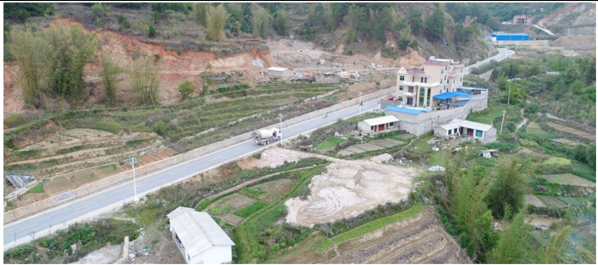
2017年12月 道路区现状情况
