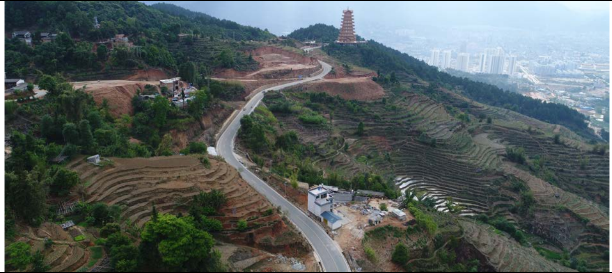
2017年12月 道路区现状情况
