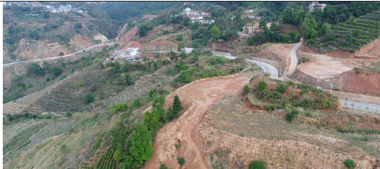
2017年12月 道路区现状情况
