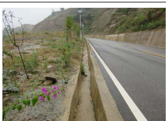
道路一侧排水沟措施
