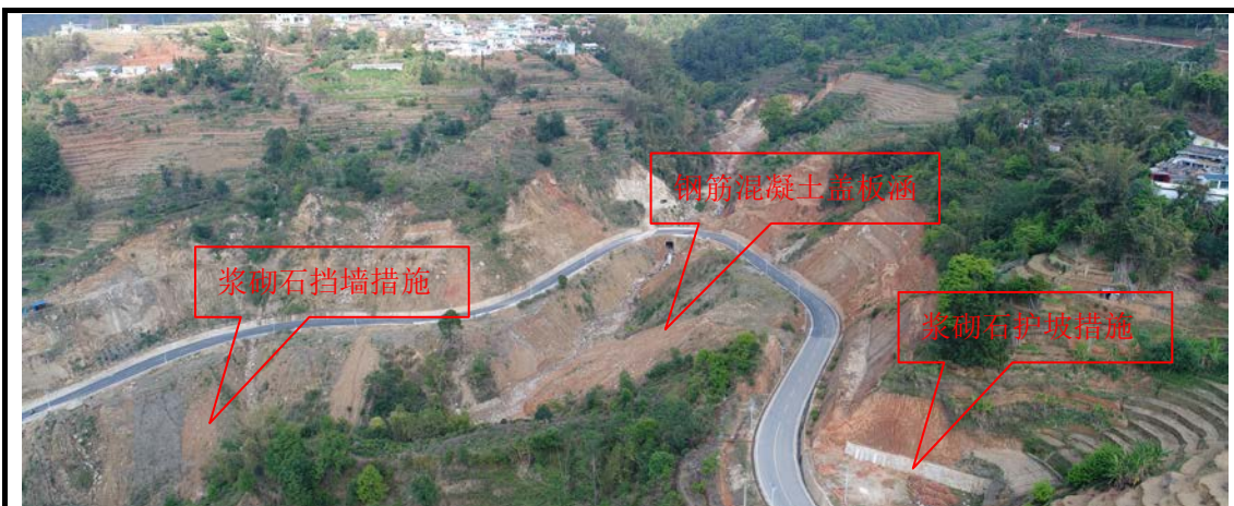
边坡防护浆砌石挡墙和护坡措施
