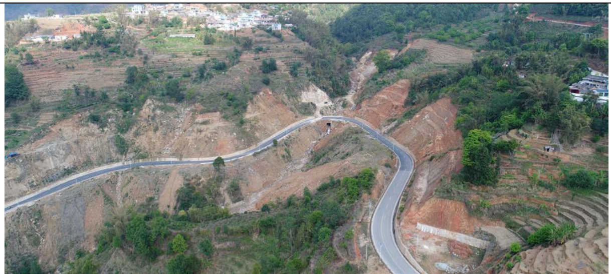
2017年12月 道路区现状情况
