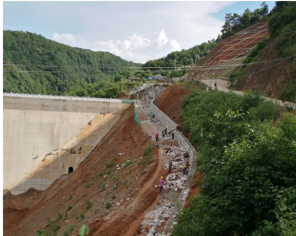
实施道路挡墙、排水沟、边坡绿化
