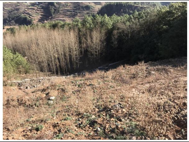
弃渣场浆砌石挡渣墙、绿化
