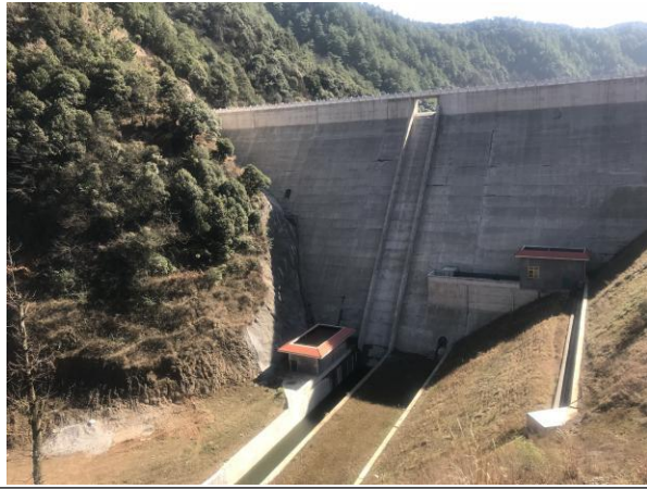
枢纽工程区大坝现状
