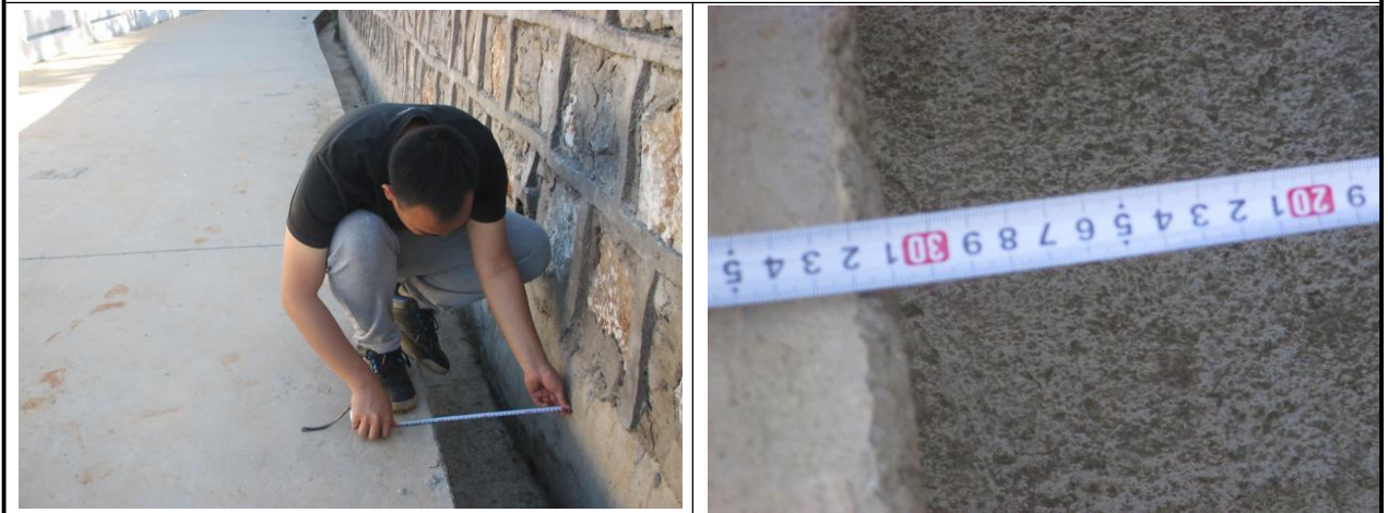
排水沟运行情况监测
