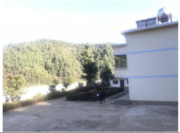
枢纽工程区管理所现状
