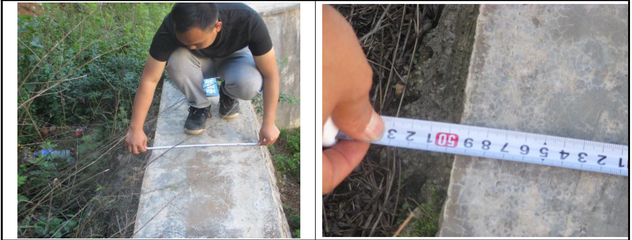
挡墙运行情况监测
