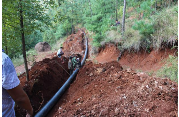
管道工程施工
