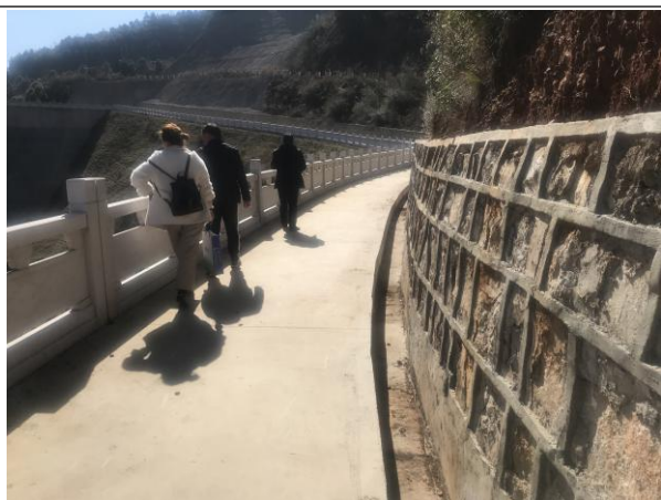
施工道路区排水沟
