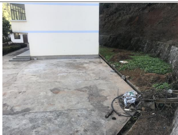
枢纽工程区管理所排水沟
