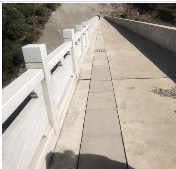
枢纽工程区排水沟
