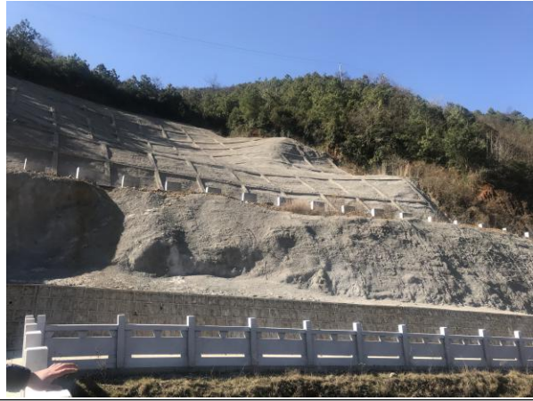
施工道路区工程护坡
