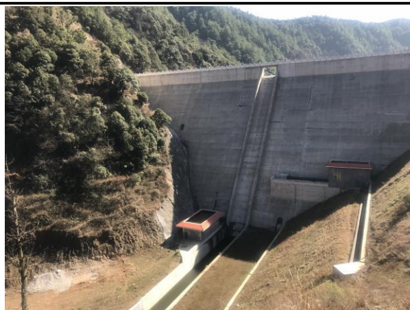
枢纽工程区大坝现状
