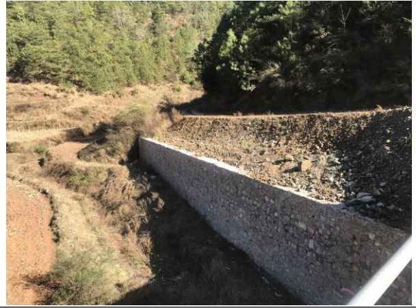
施工道路区工程护坡
