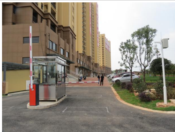
建构筑物硬化 2
