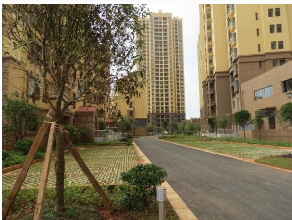
建构筑物硬化 1
