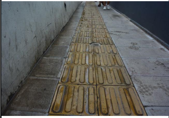
站房周边排水沟（人行道下面）
