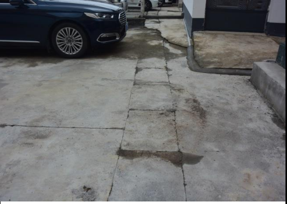
综合楼排水沟
