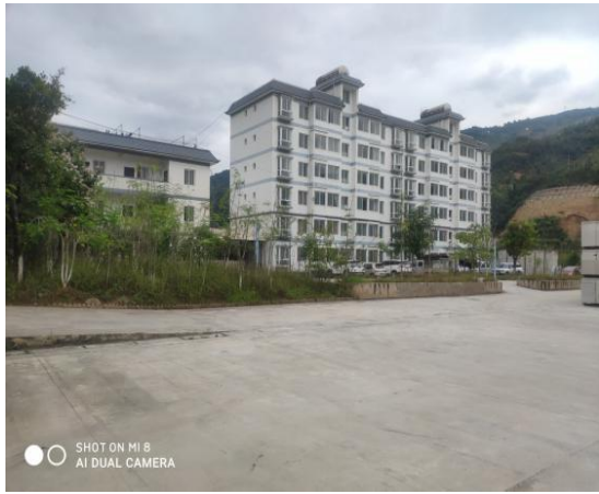
场地硬化现状
