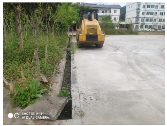
项目区排水沟现状
