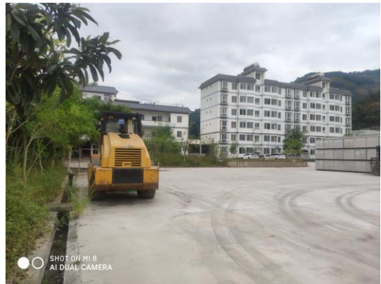
项目区排水沟现状
